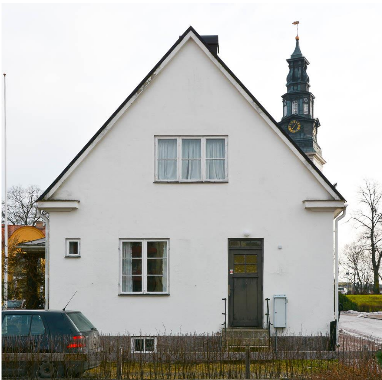
Fasad åt norr. Bild-id: vlm-kmvab-0283
