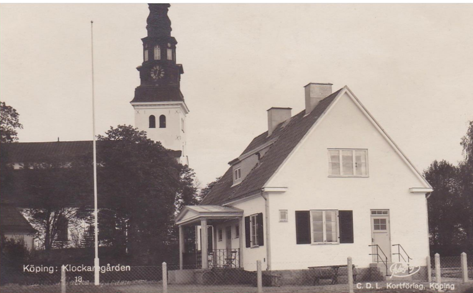
Klockaregårdens entréfasad och gavel mot nordost. Okänt årtal. Källa: Lindebilder.se/C.D.L. Kortförlag, Köping
